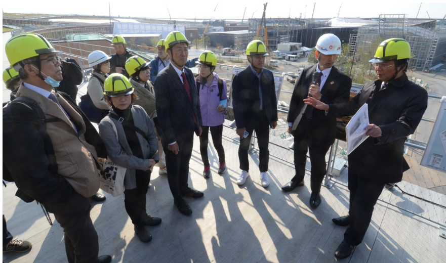
ガス爆発が起きた大阪・関西万博建設現場を調査(11月22日)
