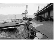
阪神淡路大震災での被害
