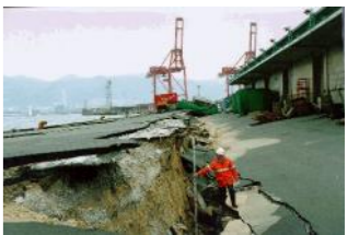
阪神淡路大震災での被害
