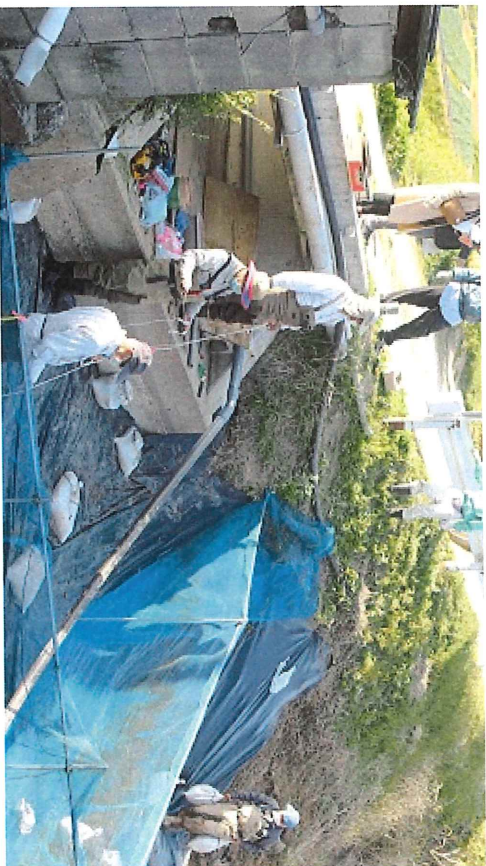
2021/4/11 【緊急対策】 ナガエツルノゲイトウが流れ出ないように排水口にネットを張る
