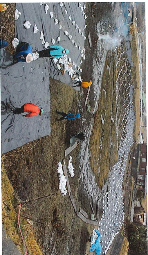
2022/2/14 その② 遮光シートを敷き、杭を打って土嚢を置く
